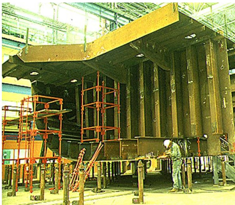
Рис.1.19 Изготовление блока судна.
