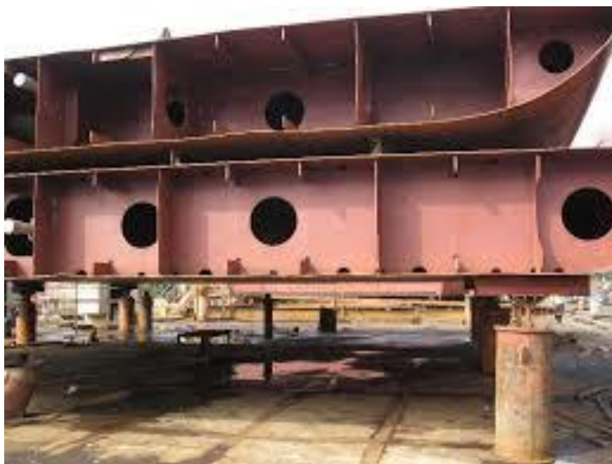
Рис.1.5 Днищевые секции двойного дна.
