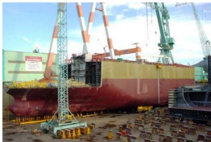
Рис.13.3 Общий вид стапеля в сухом доке В правой части-опорные устройства. Источник http://www.sqmarine.com/files/highlights/big/2012_03_09_13_05_31-Mega Block x sito.jpg
